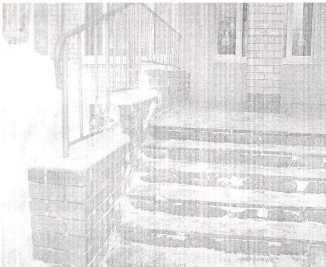
Фото №7 центральный вход
